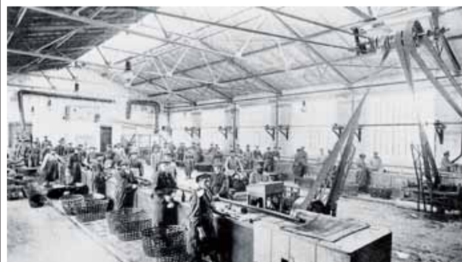
Heute würde man das, was im Sortierraum der Müll-Fabrik gesammelt wurde, Sekundär-Rohstoffe nennen. FOTO: OH
