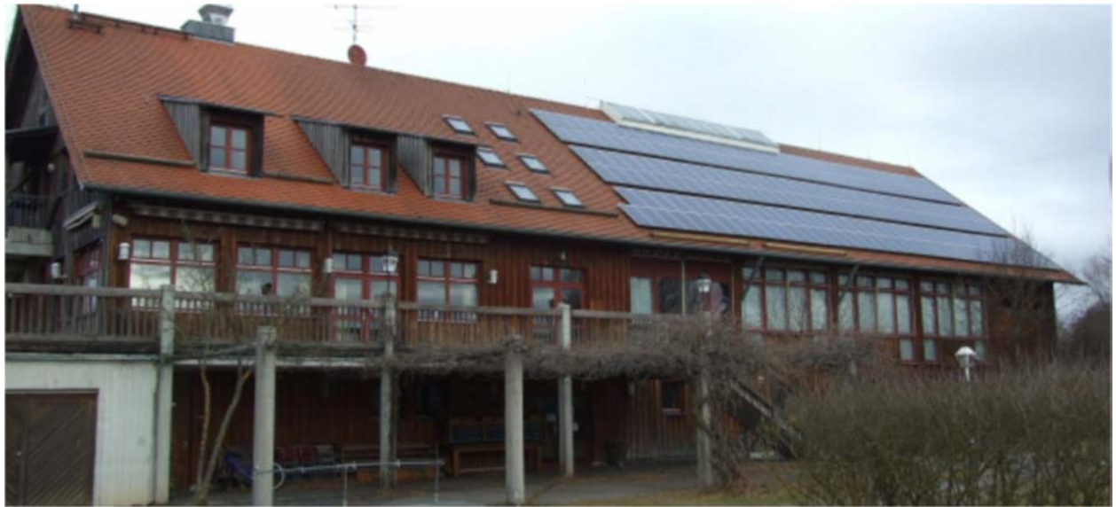
Dach des Bürgerstadels: Noch ist etwas Platz für eine weitere Solaranlage
